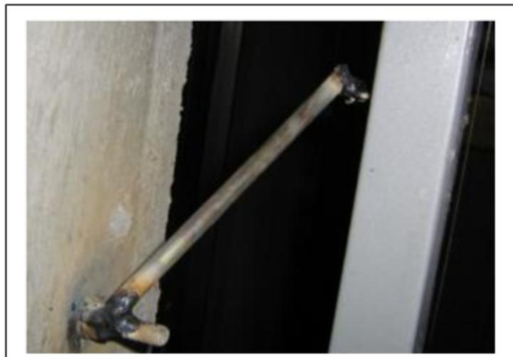
焊接时，要求圆钢与固定接触面的两面满焊，同时去除焊渣并补漆。
